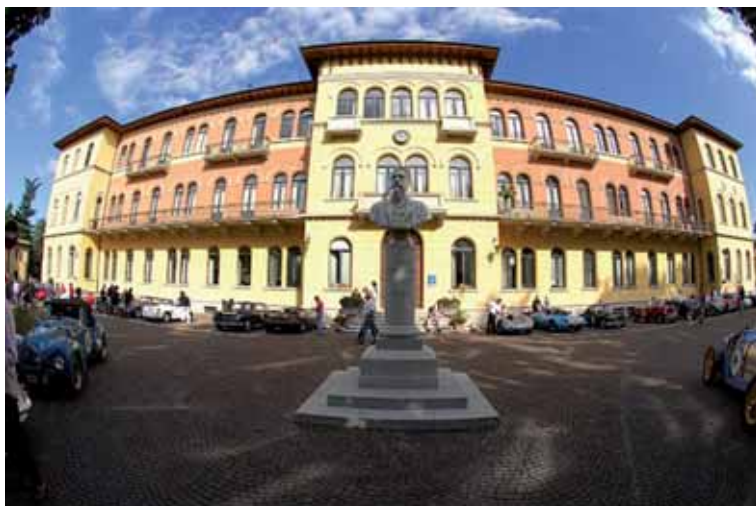
La facciata del Cerletti. Qui si formeranno i futuri tecnici superiori con specializzazione nell'ambito della sicurezza degli alimenti.
